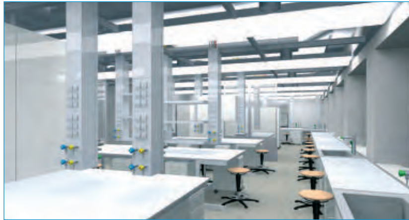
Beispiel für eine Raumversorgung über Mediendecke ■
