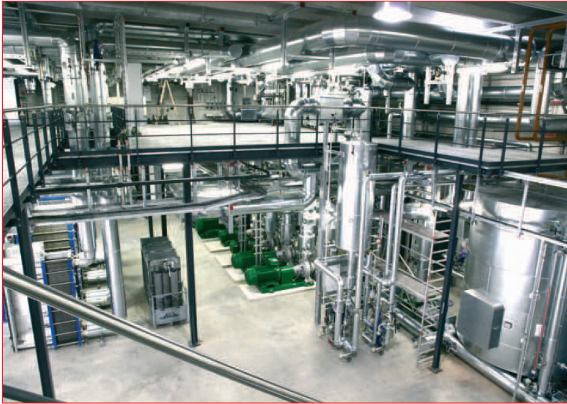
Heizwerk Laufzorn von innen ■
