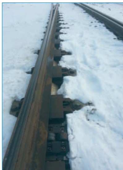
Abb. 5: Geothermische Weichenheizung Bf. Grünberg (Quelle: PINTSCH ABEN geotherm) ■
