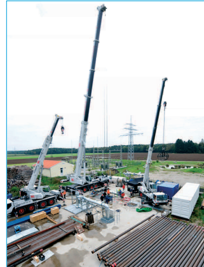
...z.B. Pumpenwechsel durch erfahrenes Personal der SWM ■
