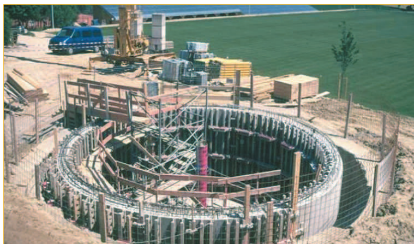
Abb. 7: Bau des Erdbecken-Speichers in Attenkirchen ■
