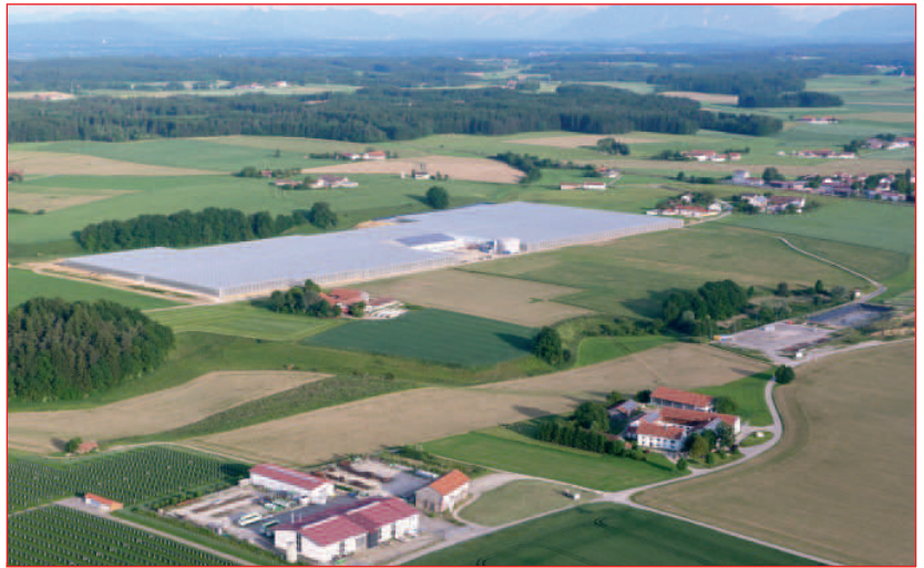
Abb. 1: Gewächshausanlage Kirchweidach, am rechten Rand der Bohrplatz ■
