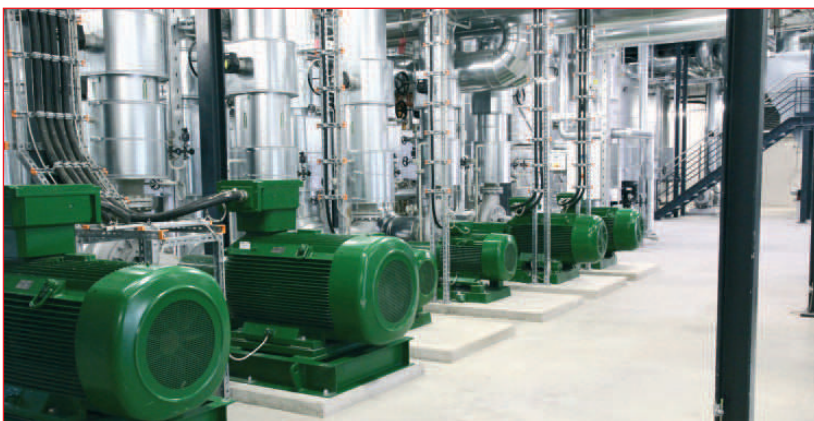
Die Wärmepumpen im EWG Geothermie-Heizwerk - für Vorlauf und Rücklauf nach Grünwald sowie Vorlauf und Rücklauf der Verbundleitung nach Unterhaching ■
