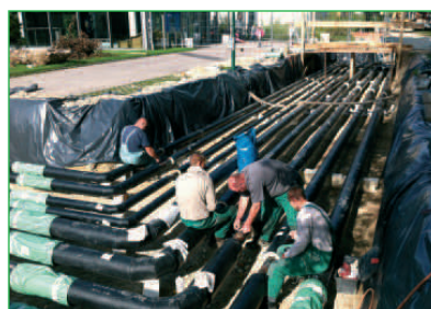
Montage des Fernwärmeanschlusses Freizeitpark Grünwald (primärseitiger 3-Leiter-Anschluss sowie sekundärseitige Anschlüsse) Copyright GEF/Hamers ■
