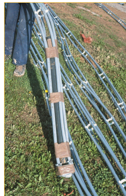
Abb. 3: Doppel-U-Erdwärmesonde mit Abstandhaltern ■
