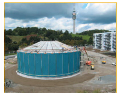
Abb. 5: Erdbeckenspeicher der Solaren Nahwärme Am Ackermannbogen in München ■
