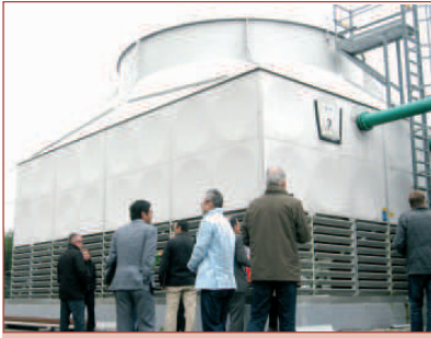
Die Kalina-Anlage des Geothermiekraftwerks in Bruchsal.
