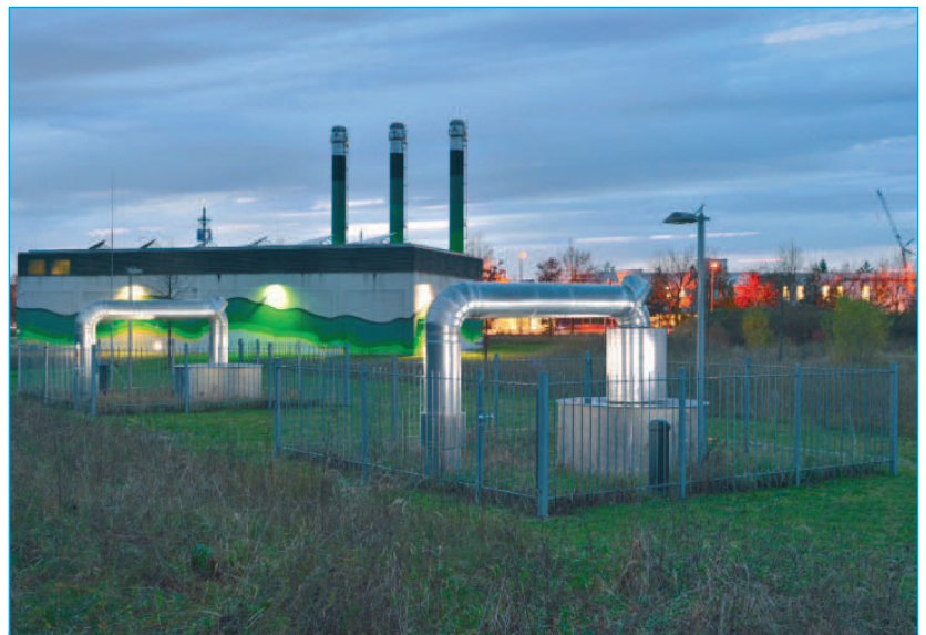
Geothermie-Anlage der SWM in München-Riem: Sichere und ökologische Wärmeversorgung für die Messestadt Riem seit 2004 ■
