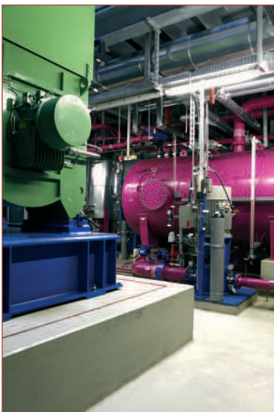
Im Inneren des Kraftwerks in Unterhaching. Foto: Geothermie Unterhaching GmbH & Co. KG ■
