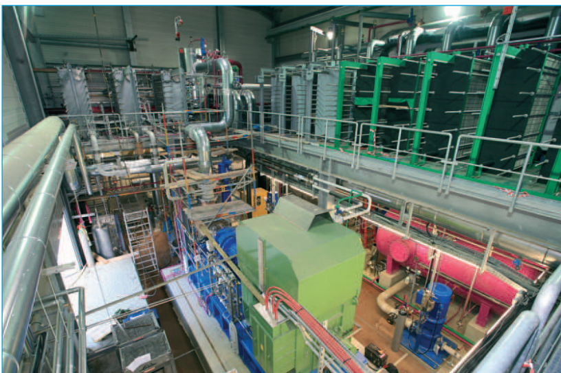
Abb. 3: Geothermiekraftwerke (hier das Kraftwerk in Unterhaching) sind komplexe Anlagen, bei denen es auf das sichere Zusammenspiel zahlreicher Komponenten ankommt (Geothermie Unterhaching) ■
