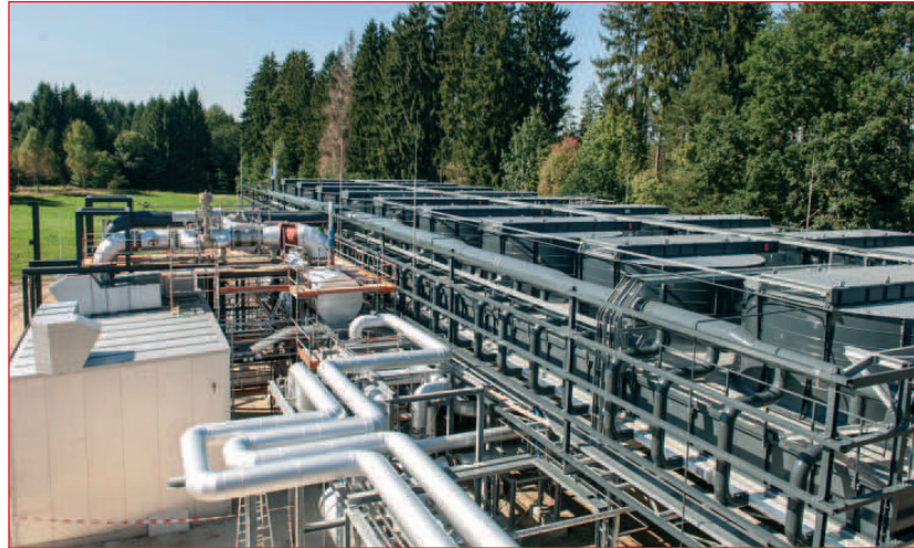
Das ORC-Stromkraftwerk der Erdwärme Grünwald produziert seit Ende 2014 grünen Strom - vorne links das Turbinenhaus, rechts die zur Kühlung eingesetzten Luftkondensatoren (Lukas) ■
