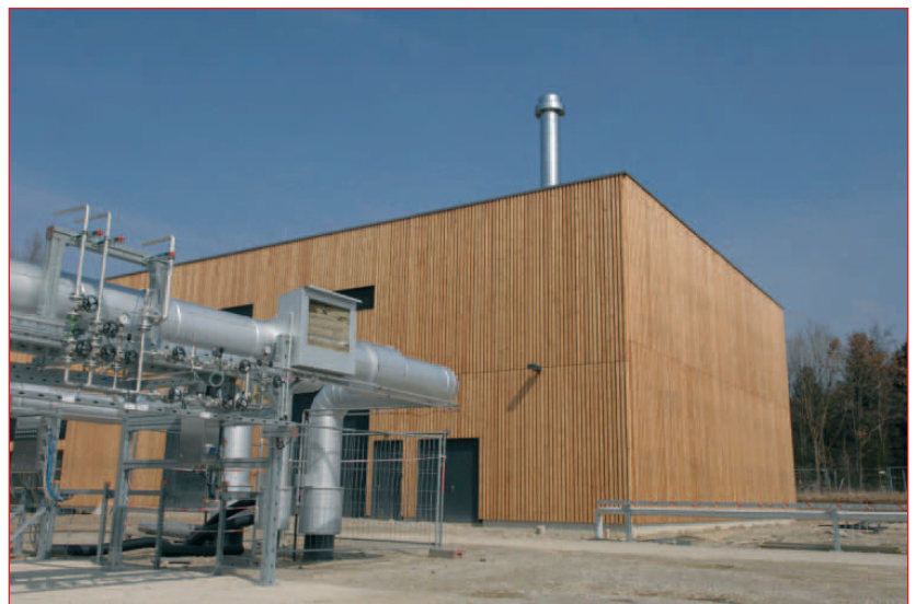
Das Geothermie-Heizwerk der Erdwärme Grünwald, in Betrieb seit November 2012 ■
