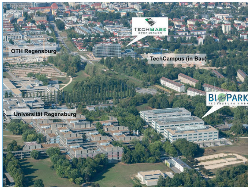
Luftbild der Technologie- und Gründerzentren BioPark und TechBase auf dem Uni-Campus Regensburg ■
