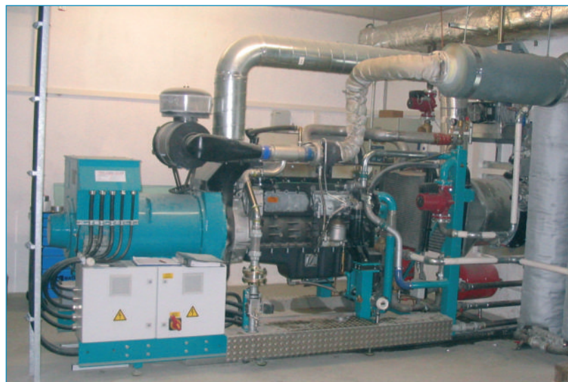
Abb. 2: Ansicht eines Biogas-BHKW mit Hubkolbenverbrennungsmotor (Bildmitte) und Generator (linkes Bild Drittel; Foto: lfl) ■
