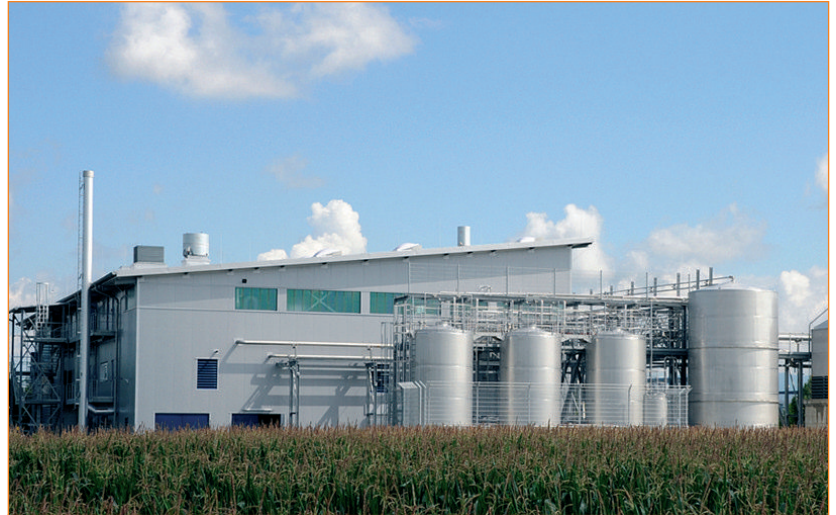
Aus Agrarreststoffen nachhaltigen Treibstoff und Grundchemikalien produzieren: das ist die Mission der Clariant Produkte (Deutschland) GmbH, die zu diesem Zweck seit 2012 ihre sunliquid® Demonstrationsanlage für Lignozellulose Bioethanol im Hafen Straubing-Sand betreibt (Foto: Clariant) ■
