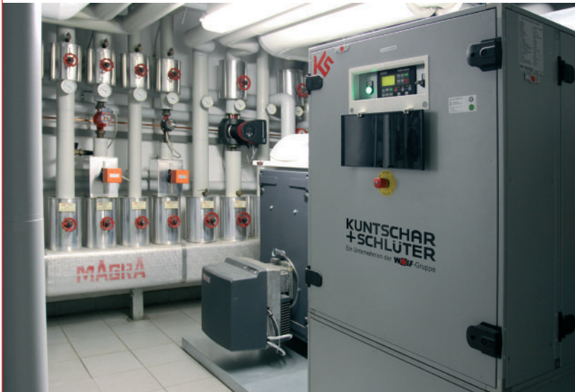
Durch die Neuordnung der Wärmeerzeugung (Erdgas anstatt Heizöl) und den Einbau eines BHKW spart der Betreiber des Fitness-Centers jährlich rund 8.000 Euro an Heizkosten und etwa 40 % der bisherigen Stromkosten ein ■
