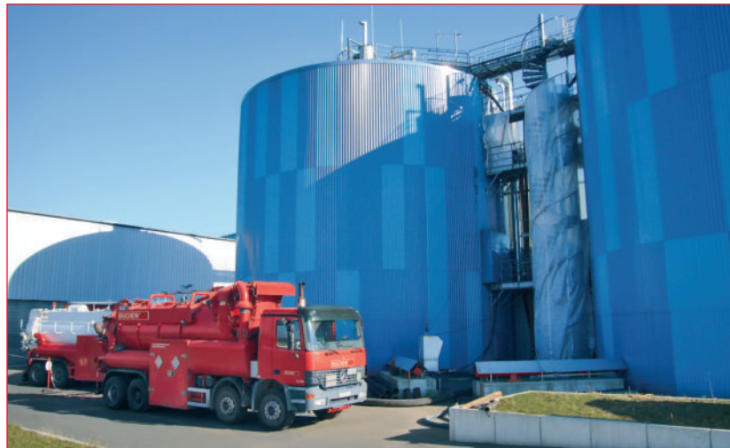
Unser mobiles Hochleistungsequipment sorgt für schnelle Problemlösungen, damit Ihre Anlage ihre optimale Leistungsfähigkeit erreicht ■
