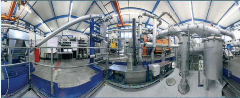
Im Technikum von Fraunhofer UMSICHT befindet sich die TCR®-Pilotanlage. Foto: Fraunhofer UMSICHT ■
