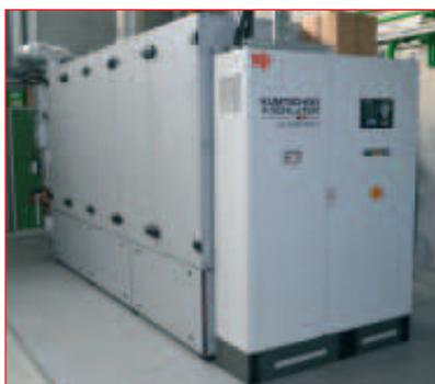
Wolf BHKW GTK 240 im Einsatz mit 365 kW thermischer Leistung und 236 kW elektrischer Dauerleistung ■
