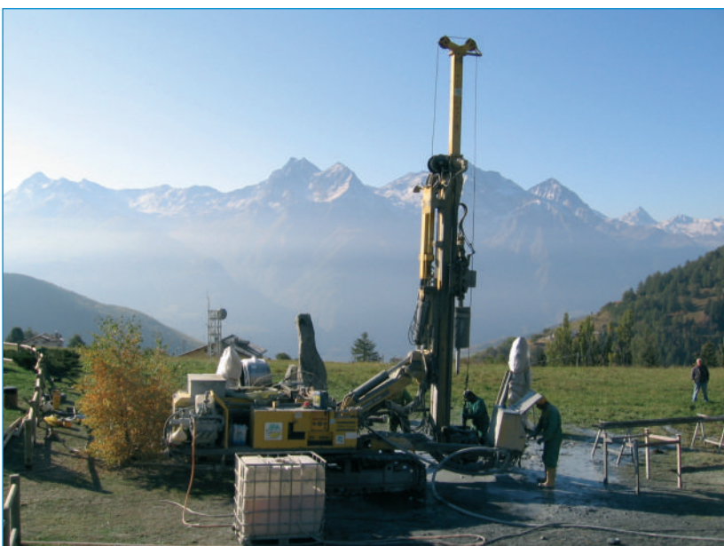
Installation einer Erdwärmesonde im Aostatal, Italien. Copyright: GRETA-Projekt ■
