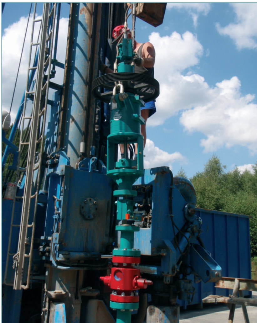
Die NTZ wurde 2009 von NETZSCH-Technikern am Brunnenstandort im Elstertal inklusive Drive Head und Gestänge montiert. ■
