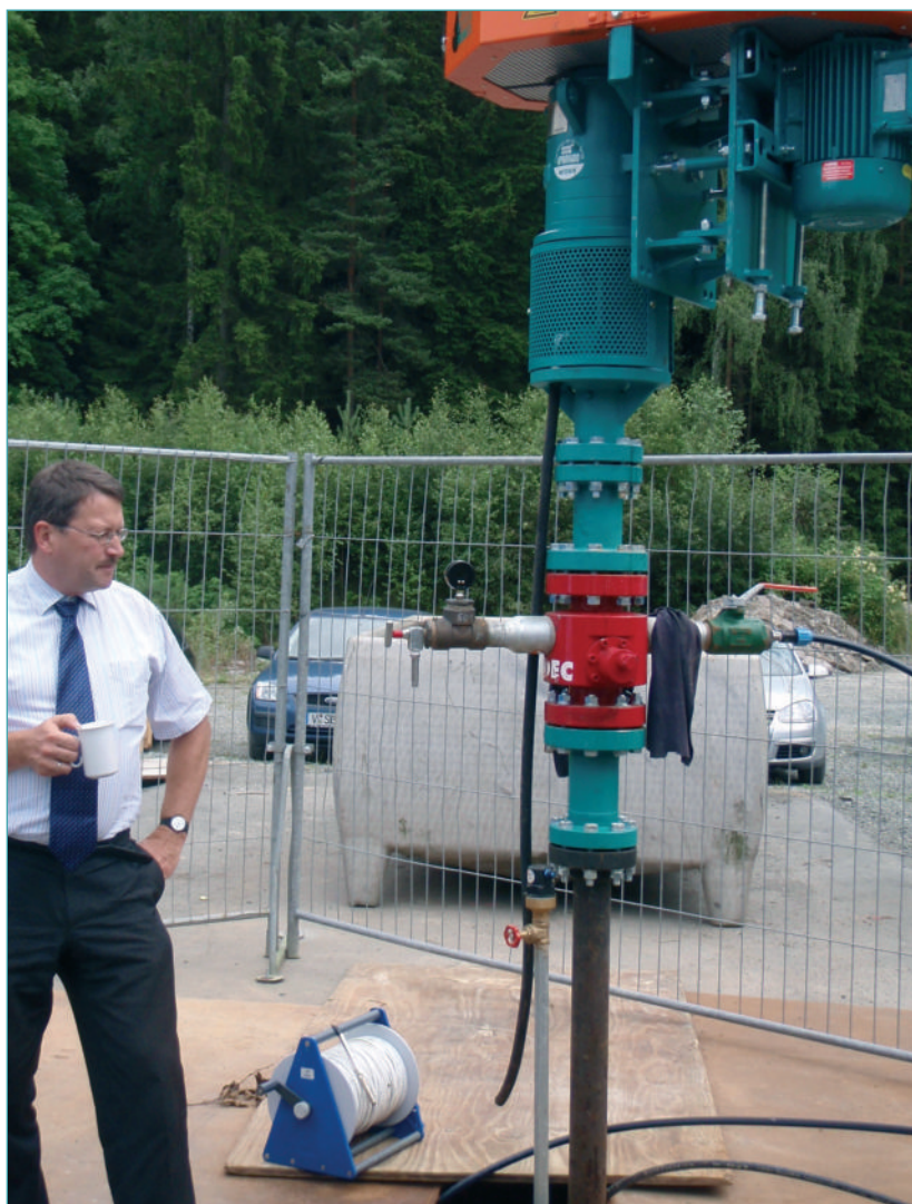
Das Quellwasser wurde zunächst im Rahmen eines Langzeitpumpversuchs gefördert – mit einer Anlage der NETZSCH Pumpen & Systeme GmbH aus Waldkraiburg. Geschäftsfeldleiter Jörg Eitler von NETZSCH Pumpen & Systeme bei der Inbetriebnahme. ■
