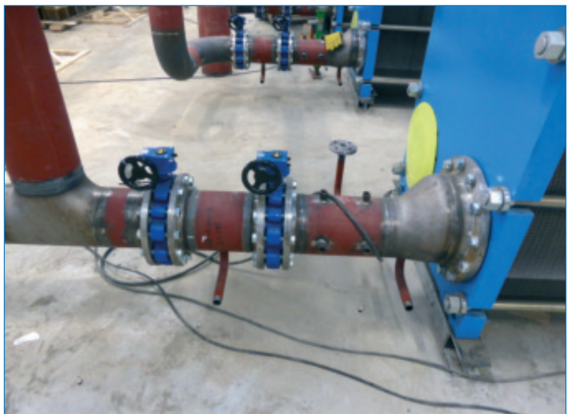
Abb. 4: Rohrleitungsanschlüsse der Wärmetauscher, die alle auf einer Seite liegen, um Wartungsfreundlichkeit zu gewährleisten.
