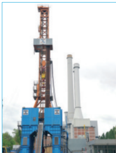
Geothermiebohrung beim Heizkraftwerk Süd der SWM ■
