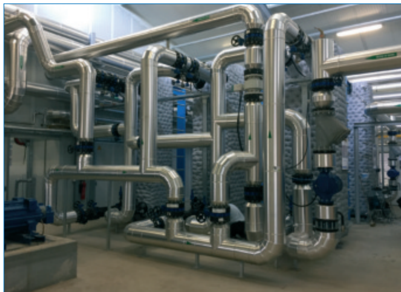
Abb. 2: Ausschnitt aus der fertigen Anlage mit den 4,5 Meter hohen und 6,5 Tonnen schweren Wärmeaustauschern nach erfolgter Installation im Gebäude. Quelle: gec-co Global Engineering & Consulting-Company GmbH ■
