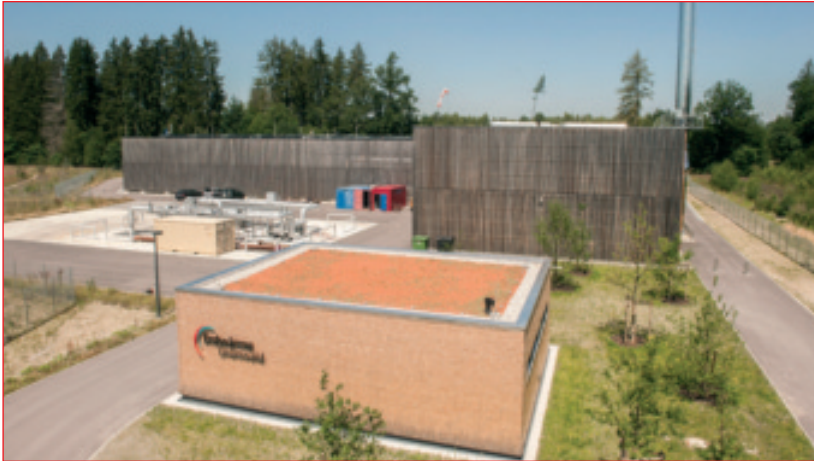
Die Geothermieranlage der Erdwärme Grünwald in Laufzorn ist harmonisch in die Landschaft eingebettet. Links des Heizwerks und vor dem ORC-Stromkraftwerk ist die Dubletten-Bohrung zu sehen: Produktions- und Reinjektionsbohrung sind jeweils über 4.000 Meter tief; die EWG fördert hier robuste 120 Liter / Sekunde mit einer Temperatur von 127 Grad Celsius. ■
