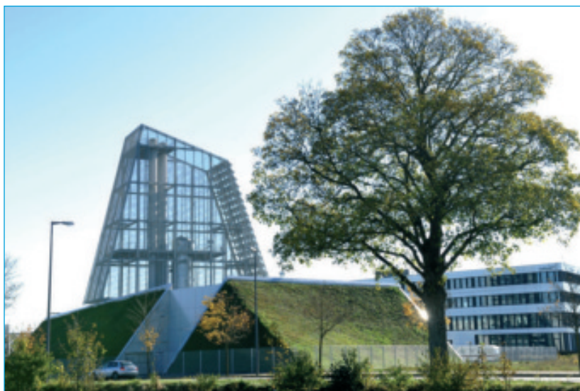
Geothermieanlage und Heizwerk Freiham der SWM ■
