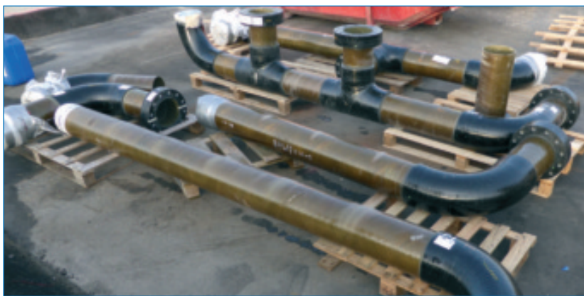
Abb. 5: Angelieferte GFK-Rohre auf der Baustelle des Geothermie-Heizwerkes in Poeldijk.
