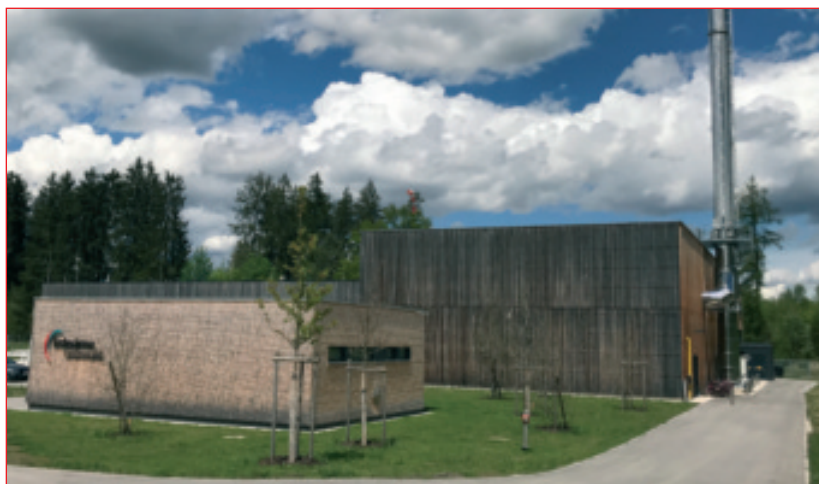
Die Geothermieanlage der Erdwärme Grünwald in Laufzorn: rechts das Geothermie-Heizwerk, in dem auch das Blockheizkraftwerk zur Eigenstromerzeugung und die Power-to-Heat-Anlage platziert sind, im Vordergrund der Infopavillon, hinten links das ORC-Stromkraftwerk. ■
