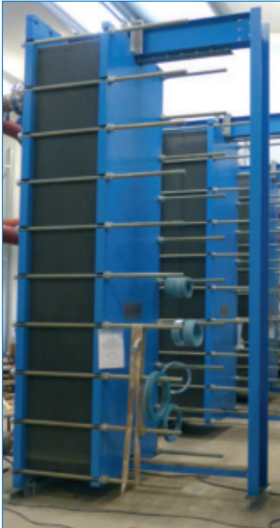
Abb. 3: Eingängige Wärmetauscher im Einbauzustand.
