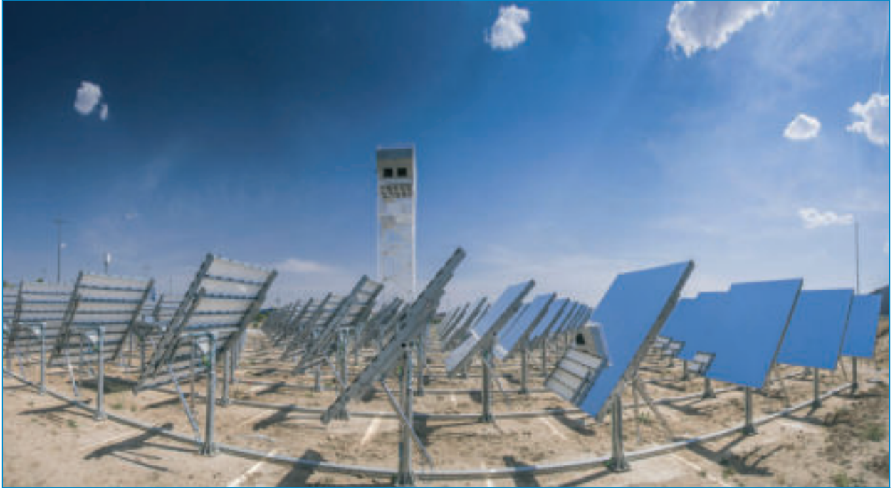
EU-Projekt „SUN-to-LIQUID“-Versuchsanlage in Móstoles, Spanien ■
