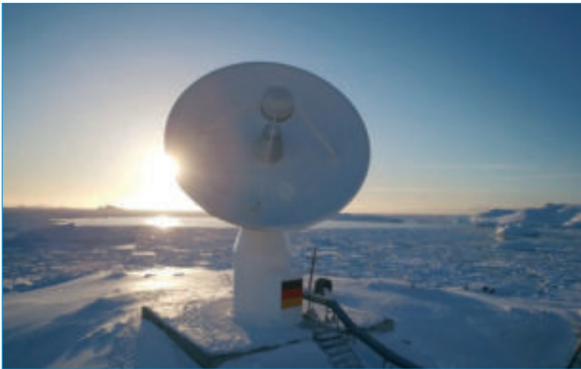
Abb. 2: Die DFD-Empfangsstation GARS O'Higgins befindet sich in der Antarktis. Nahe dem Süd- oder auch Nordpol sind besonders häufige Satellitenkontakte möglich. Dadurch können große Datenmengen empfangen werden. ■
