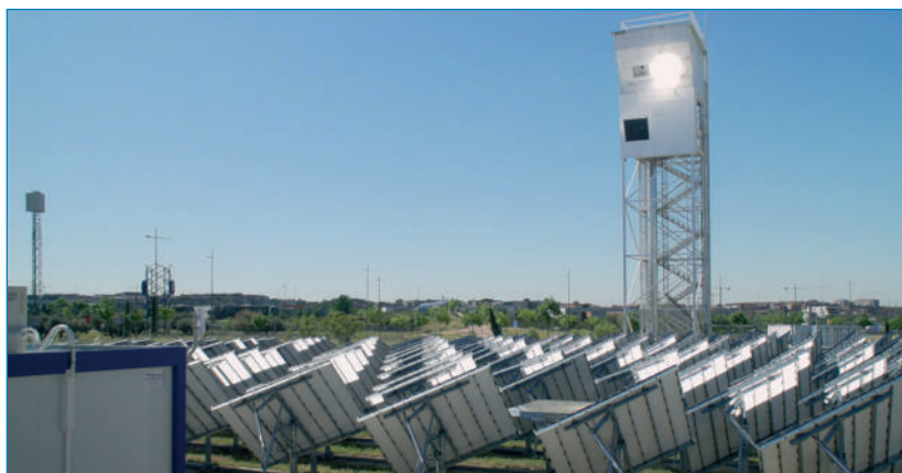
Abb. 1: Demonstrations-Anlage zur Erzeugung von solaren Kraftstoffen im Projekt SUN-to-LIQUID (Photo Credit: Christophe Ramage, © ARTTIC 2019) ■
